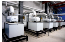
Вакуумная установка электронно-лучевой сварки
